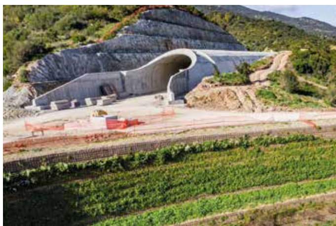
Terre rinforzate variante della S.S. 125 Orientale sarda Tertenia (OG), Italia
