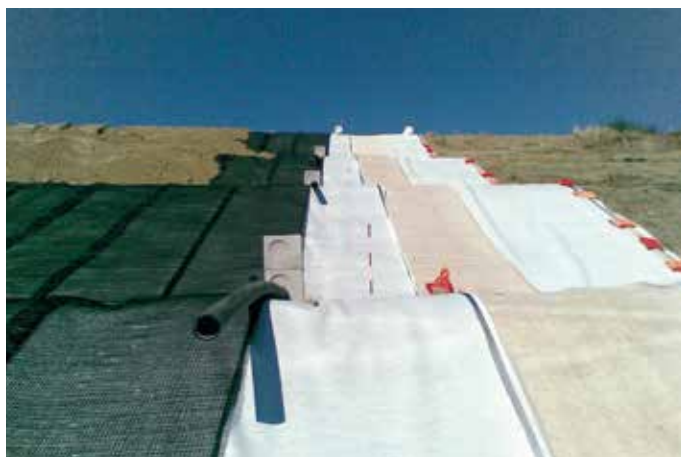
Capping di una discarica Ravenna (RA), Italia
