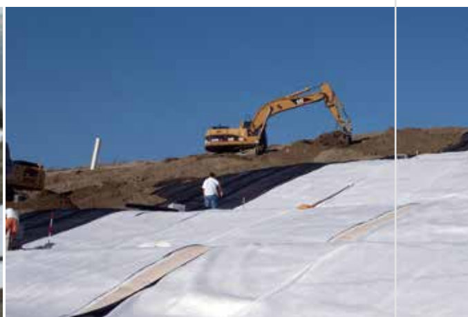
Capping di una discarica Ravenna (RA), Italia
