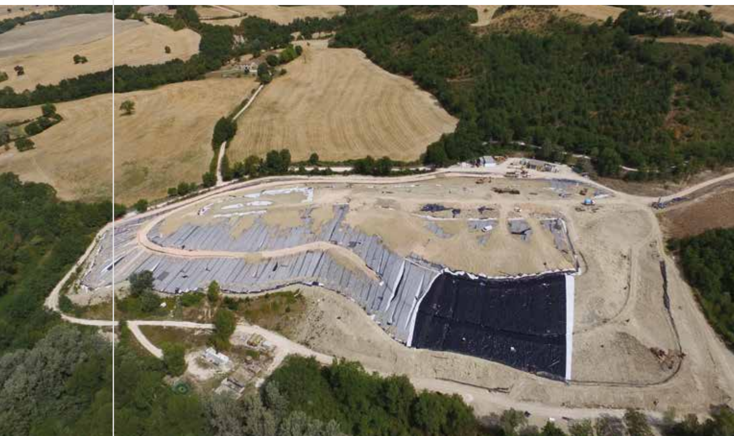
Capping di discarica Cagli (PU), Italia
