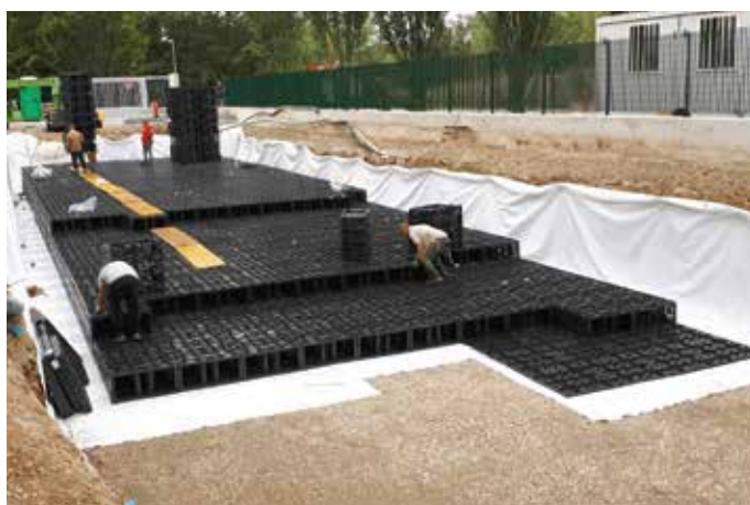
Misure di invarianza idraulica per un ampliamento industriale Busnago (MB), Italia
