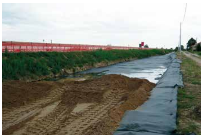
Rinforzo fondazione autostradale A31 Italia, Rovigo (RO)
