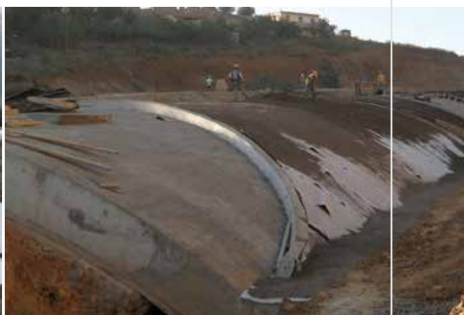
Drenaggio e separazione in tunnel autostradali Constantine-Skikda, Algeria
