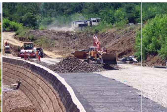
Opera di sostegno in terra rinforzata per l'autostrada A3 nel tratto SA-RC Lauria (PZ), Italia
