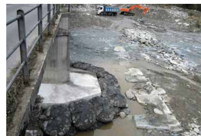
Protezione della pila di un ponte in alveo Villar Pellice (TO), Italia
