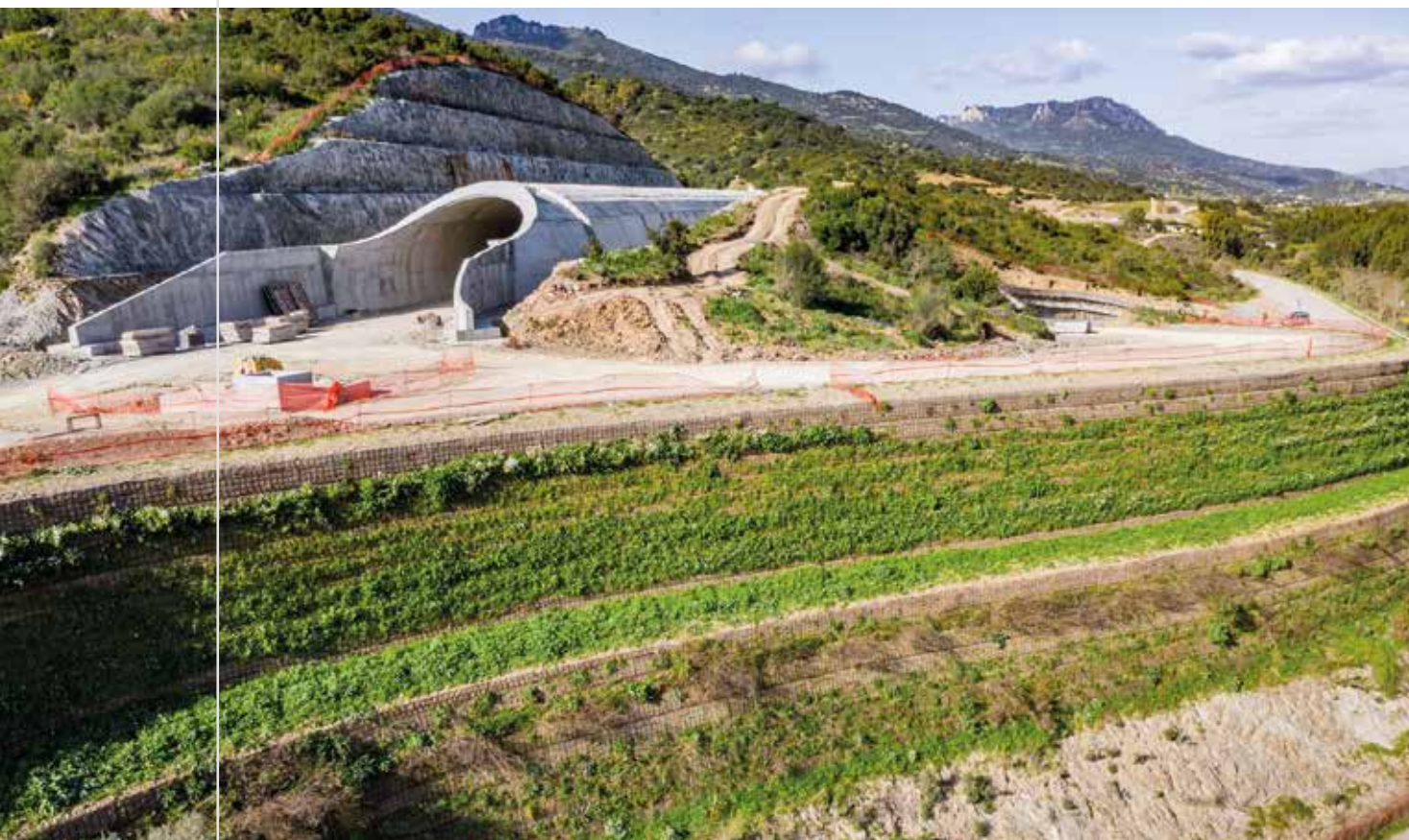
Terre rinforzate S.S. 125 orientale sarda Tertenia (OG), Italia
