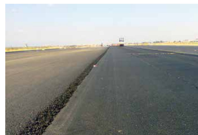
Risanamento pista aeroportuale Aeroporto di Cagliari, Italia
