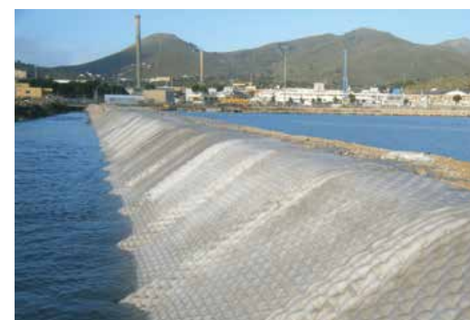
Protezione e controllo erosione di argini in vasca di colmata Porto di Gaeta (LT), Italia
