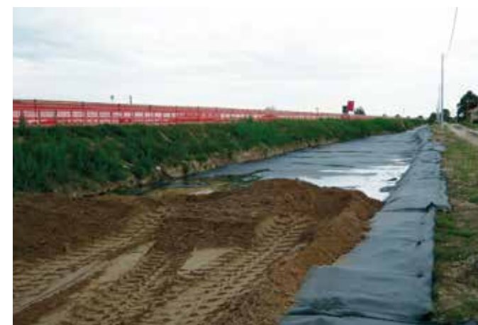
Rinforzo fondazione autostradale A31 Italia, Rovigo (RO)
