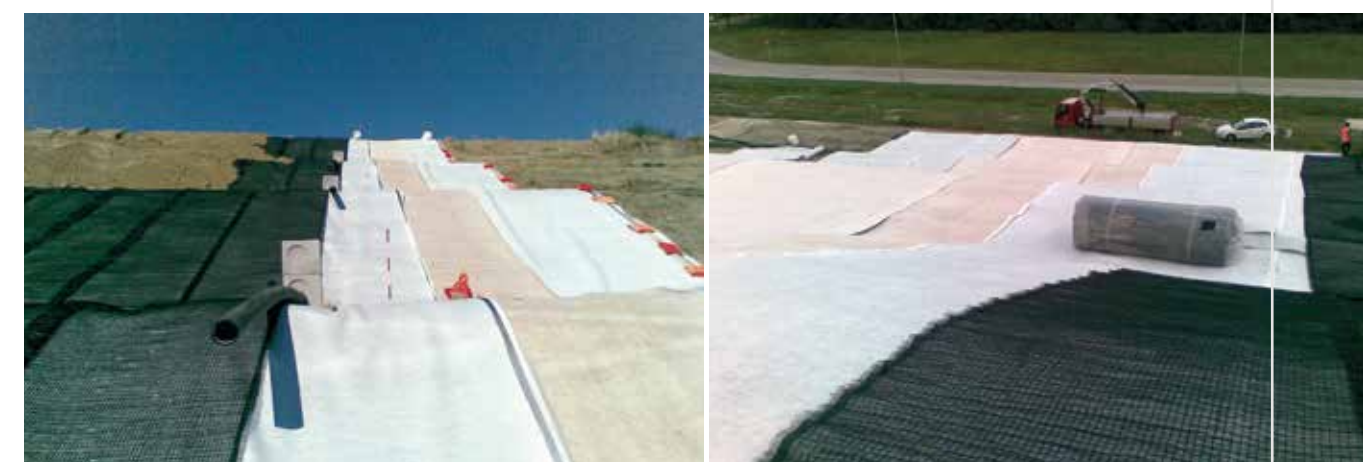
Capping di una discarica Ravenna (RA), Italia
