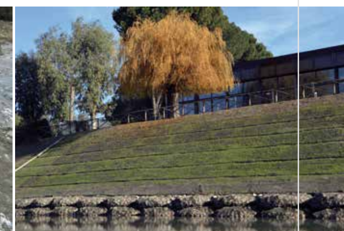
Argini in terra rinforzata e protezione al piede degli argini nel fiume Tevere Roma, Italia
