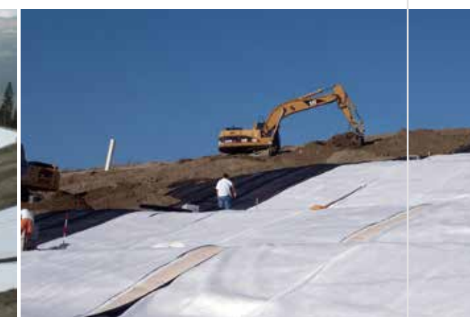
Capping di una discarica Ravenna (RA), Italia
