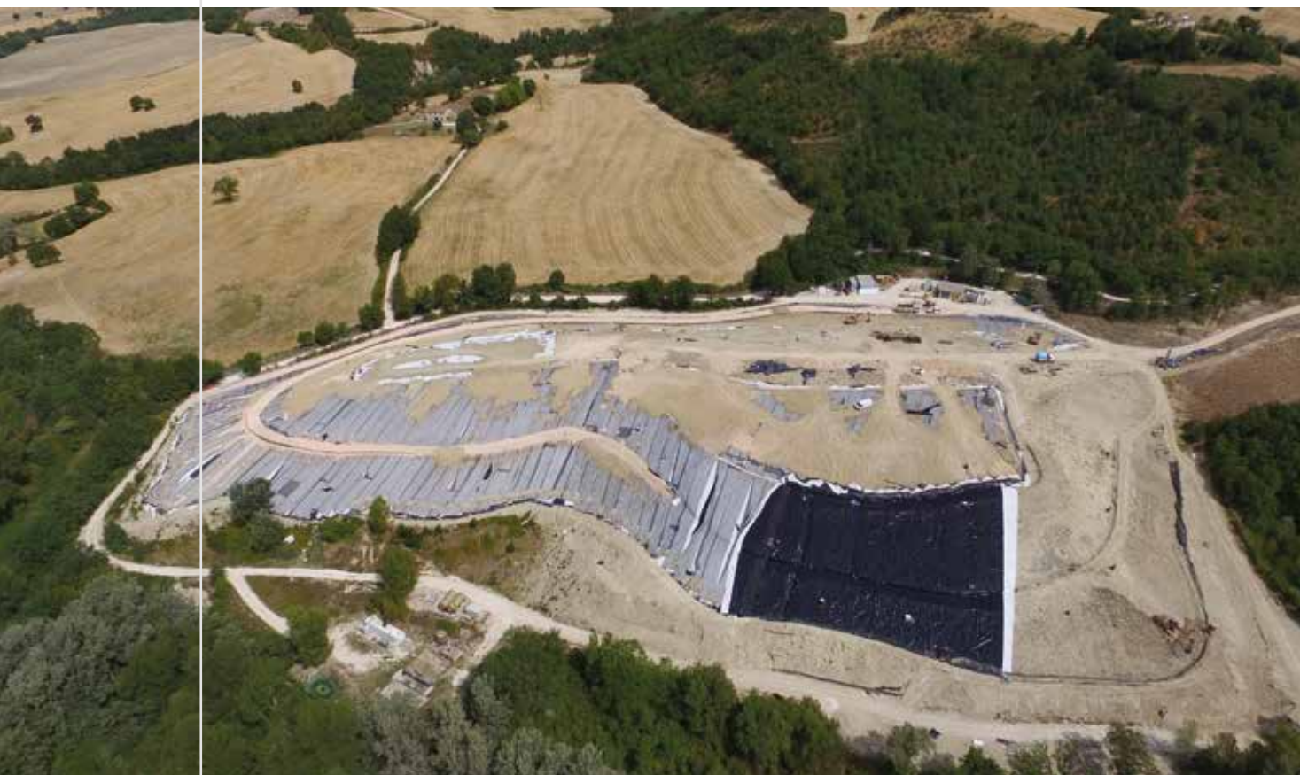
Capping di discarica Cagli (PU), Italia
