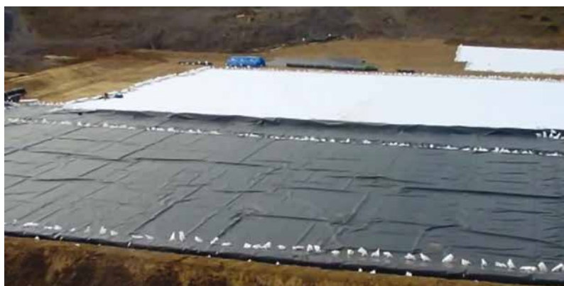
3. Un nontessuto a protezione di una geomembrana
