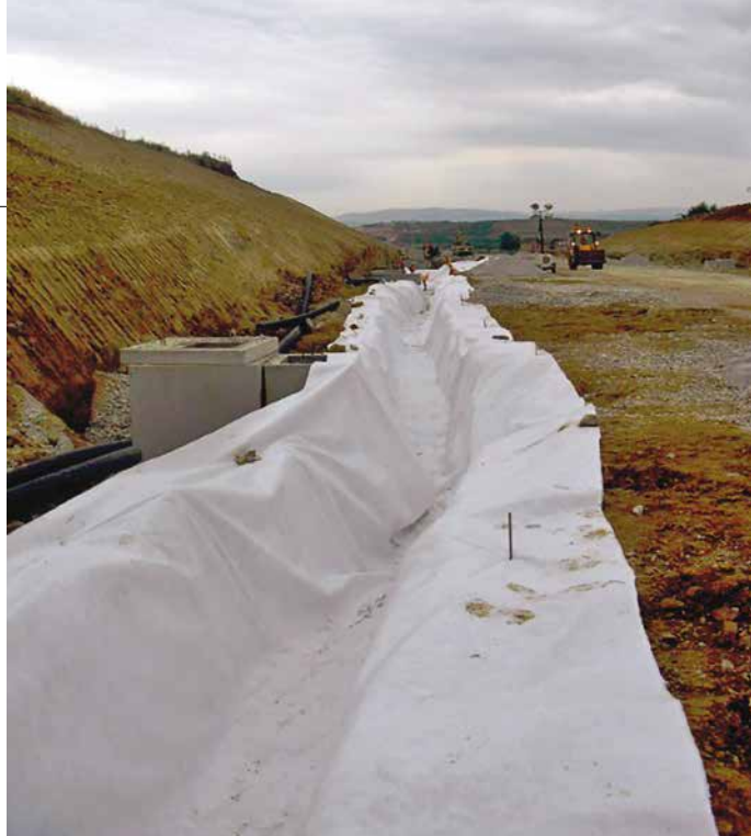
7. Il rivestimento delle trincee drenanti sulla Autostrada R7 in Kosovo
