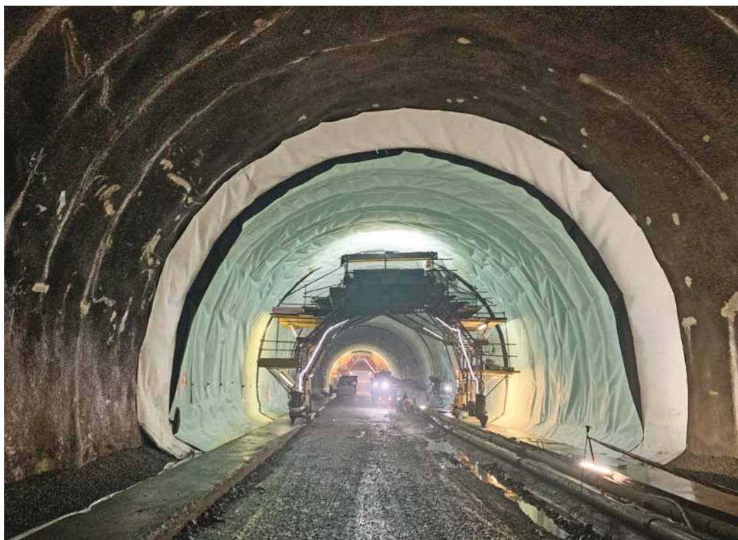
8. L'interno del tunnel in costruzione. Si nota il geotessile (bianco) a protezione della geomembrana (verde)
