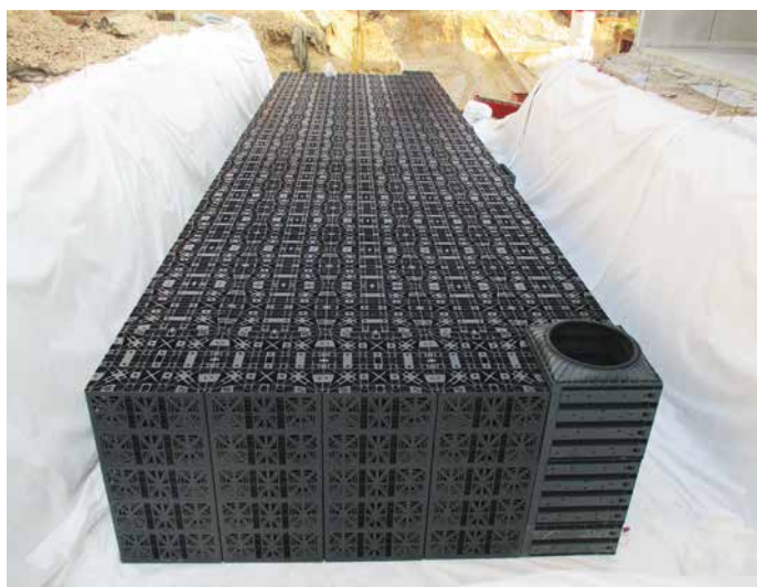
5. Il bacino drenante con blocchi modulari in PP, tipo GRAF Ecobloc Inspect Flex
