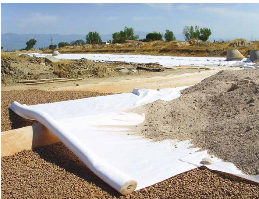
1. Un sottofondo stradale e il nontessuto di separazione
