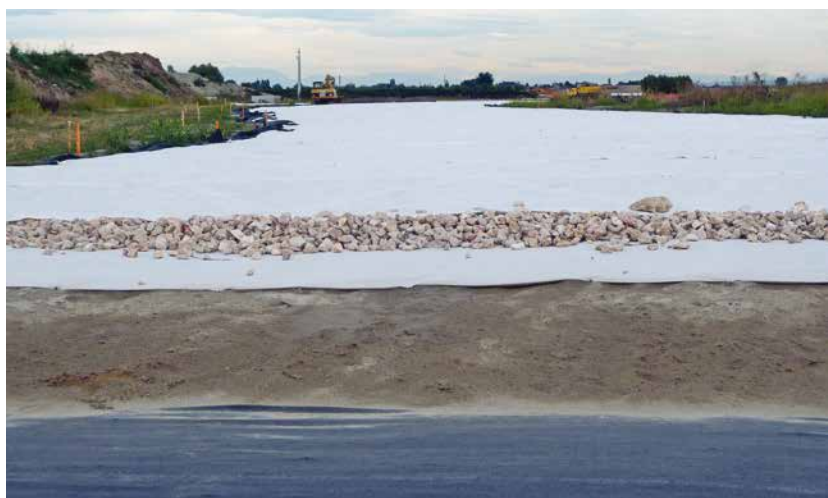
4. La realizzazione del sottofondo di un tratto dell'Autostrada A31
