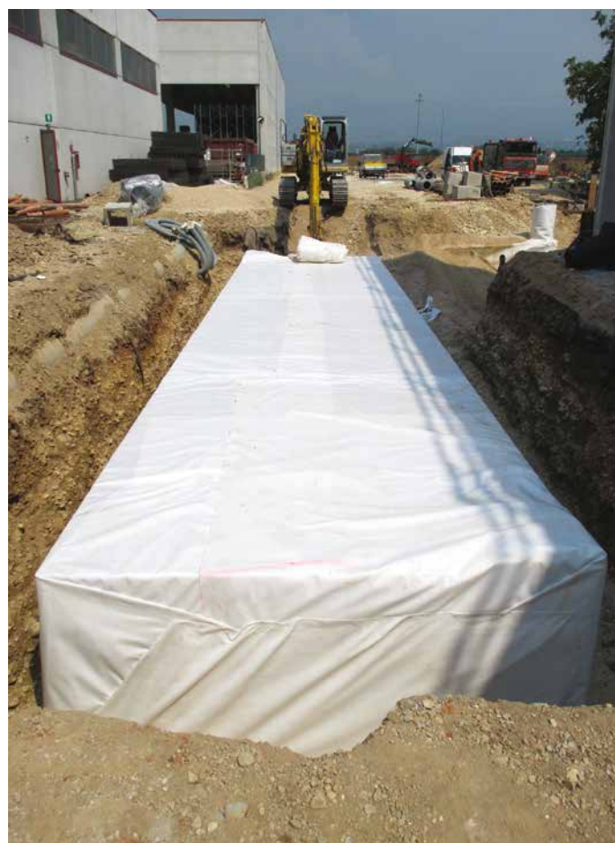
6. La struttura modulare ricoperta su tutti i lati dal geotessile nontessuto
