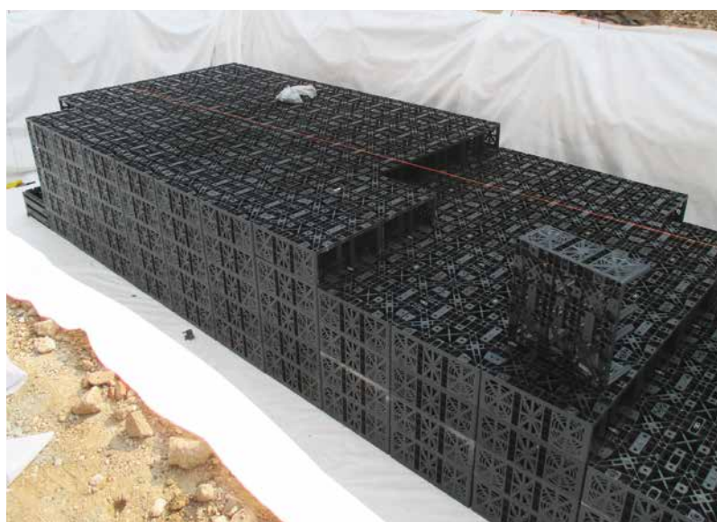
2. Il montaggio di un bacino realizzato con elementi modulari
