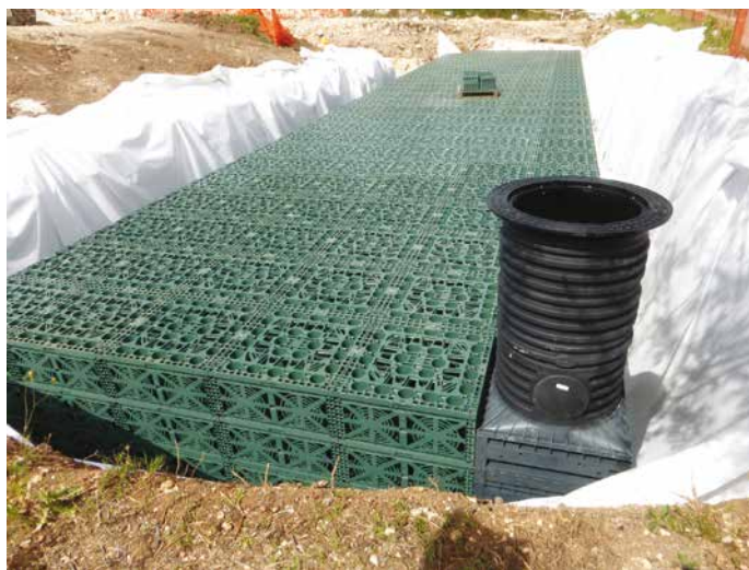
8. Una delle sei trincee drenanti realizzate
