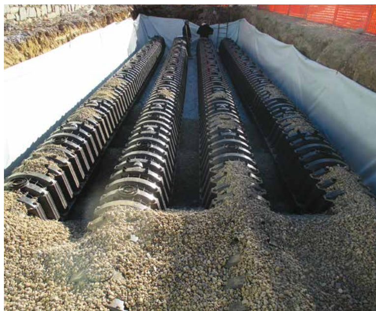
10. Vista delle trincee drenanti prima del rinterro finale
