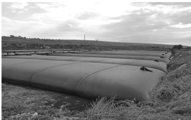
Figura 1 – Esempio di applicazione di geo-tubi per lo stoccaggio e la deidratazione di fanghi industriali (cortesia Geosintex srl).
