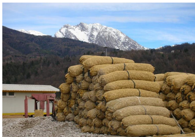
Fig. 6.2 : Burghe e materassi ad alta e media resistenza realizzati in geogriglia in fibre di poliestere e riempite con pietrame o con conchiglie o limi aggregati con legante minerale o con conchiglie sciolte
