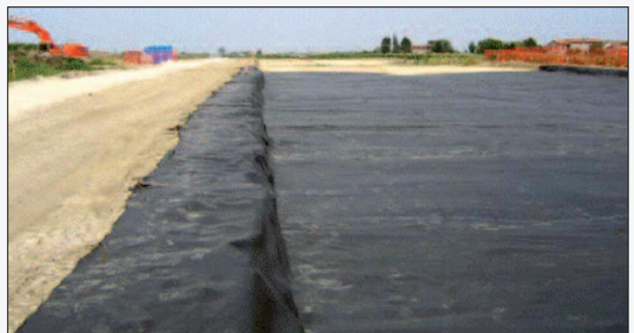
Figura 1 - Un geosintetico di rinforzo può cambiare le condizioni al contorno del sottofondo, migliorandone le prestazioni
